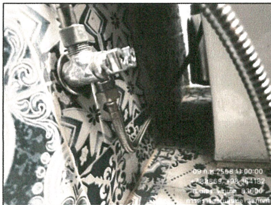
รูปภาพที่ 2.53 การตรวจสอบสายท่อจ่ายน้ำ
