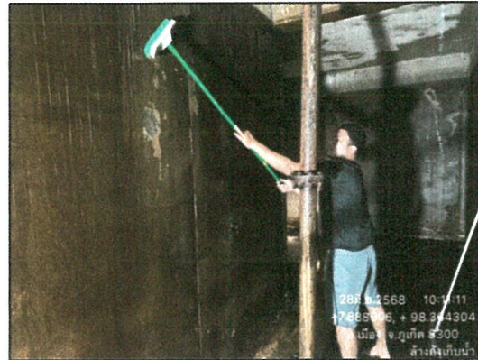
รูปภาพที่ 2.52 การล้างถังเก็บน้ำ
