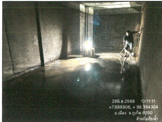
รูปภาพที่ 2.52 การล้างถังเก็บน้ำ
